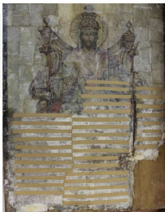
En cours de refixage
